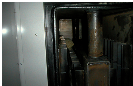
3. För in sotviskan i konvektionen.
