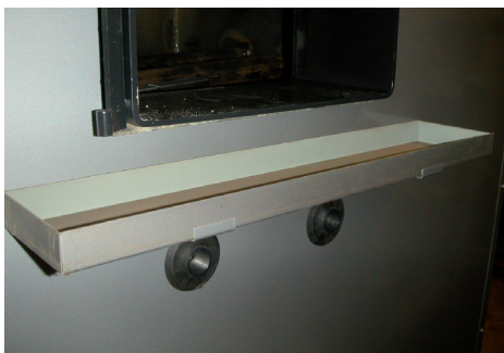
6. Eldstaden behöver normalt inte rengöras. Rätt inställd förbränning håller eldstaden ren. På bild askhylla, placerad under eldstadens lucköppning.
