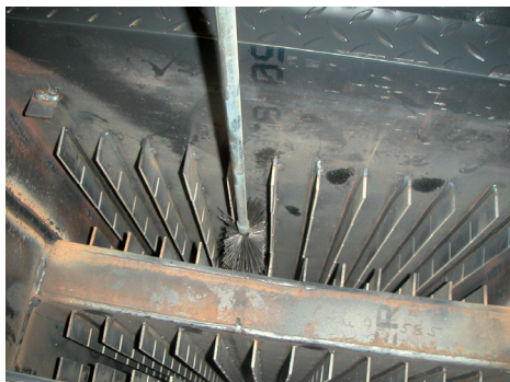
2. Montera sotviska på skaftet och rengör konvektionen.
