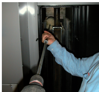
4. Rätt grepp, andra handen i bormaskinen och andra i skaftet.
